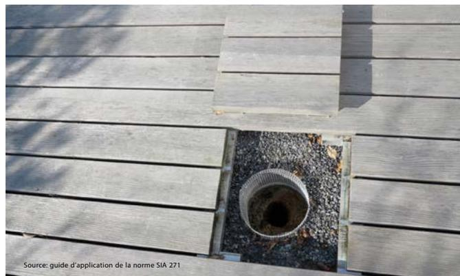
Fig. 43: pour les caillebotis en bois, il n'est pas nécessaire de prévoir une grille d'entrée des eaux de pluie. Il devrait toutefois y avoir une ouverture de service au niveau de l'entrée des eaux.
