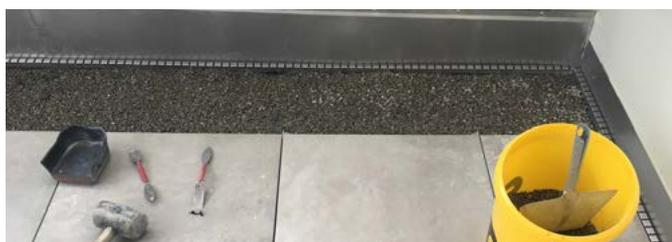
Fig. 5: pose des dalles en céramique / grès cérame sur une couche d'assise en gravier rond.
