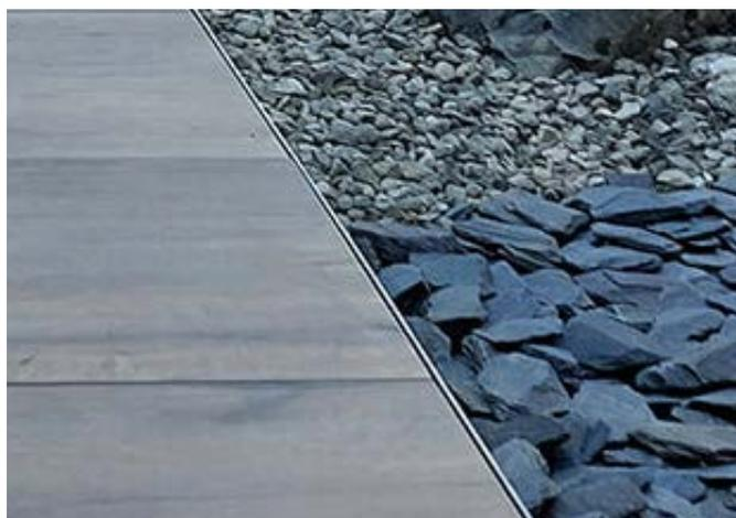
Fig. 34: raccord de bord avec cornière métallique ou entretoise.
