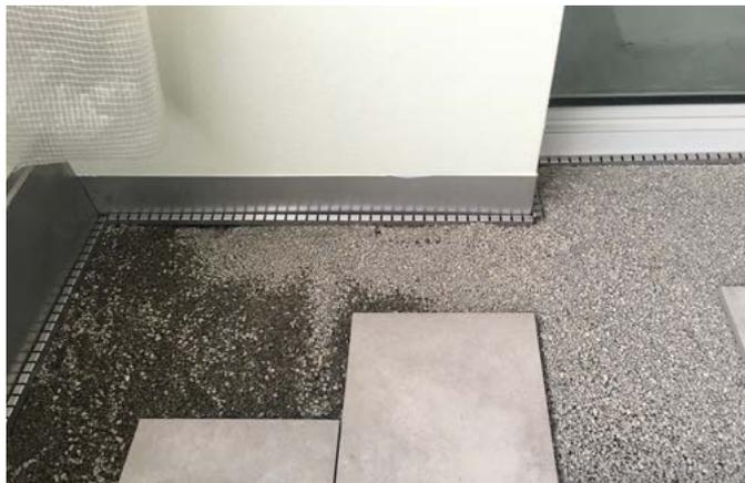
Fig. 24: terrasse avec dalles en céramique / grès cérame posées sur couche d'assise.
